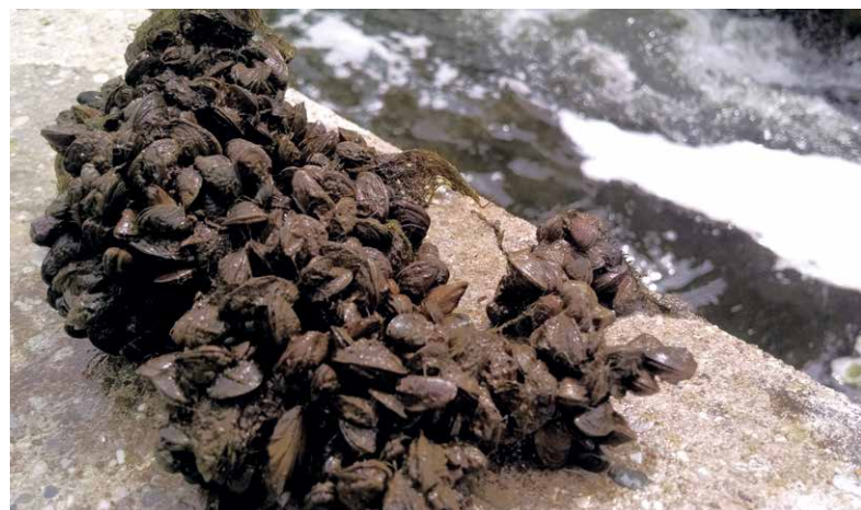
■ Massenvorkommen in einer Vertikal-Slot-Fischaufstiegsanlage
